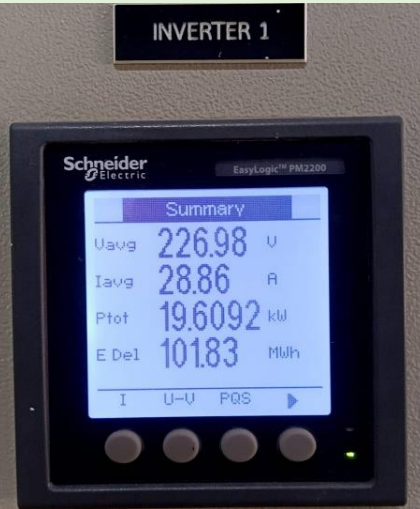
หน้าจอแสดงผลรวมการ ผลิตไฟฟ้าจาก Inverter
