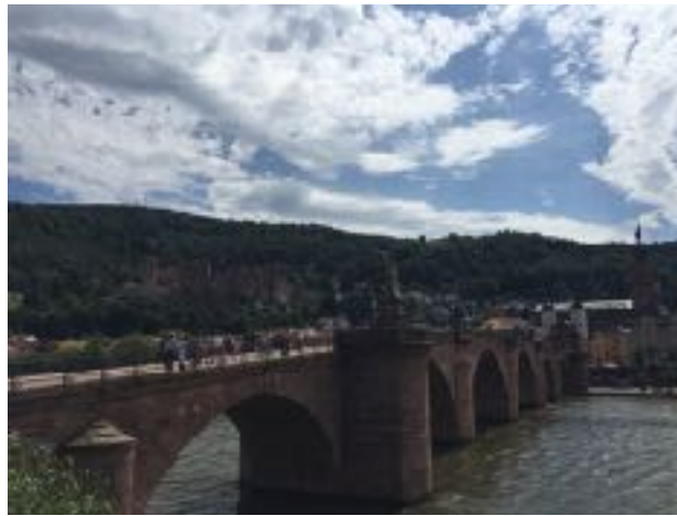
สะพานเก่าของเมือง Heidelberg
