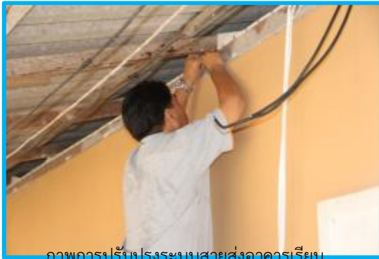
ภาพการปรับปรุงระบบสายส่งอาคารเรียน
