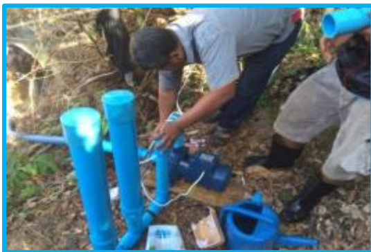
ภาพการติดตั้งระบบสูบน้ำ ให้โรงเรียน
