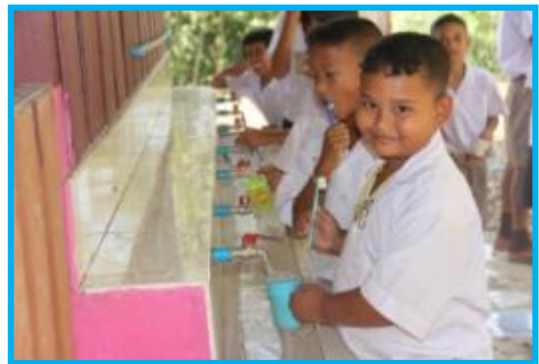
ภาพการใช้น้ำเพื่ออุปโภคของนักเรียนโรงเรียน ตชด. บ้านควนสามัคคี ภายหลังติดตั้งระบบสูบน้ำให้โรงเรียน
