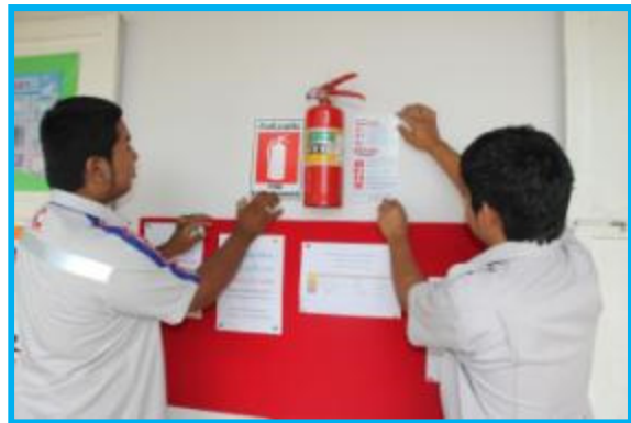
ภาพการติดตั้งถังดับเพลิงตามอาคาร และอุปกรณ์ป้องกัน ไฟฟ้าลัดวงจร
