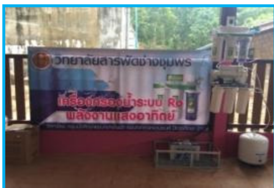
ติดตั้ง เครื่องกรองน้ำระบบ RO (Reverse Osmosis) ของวิทยาลัยสารพัดช่างชุมพร
