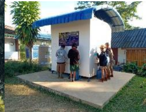
นักเรียนกรอกน้ำผ่าน อาคารบ้านน้ำดื่ม
