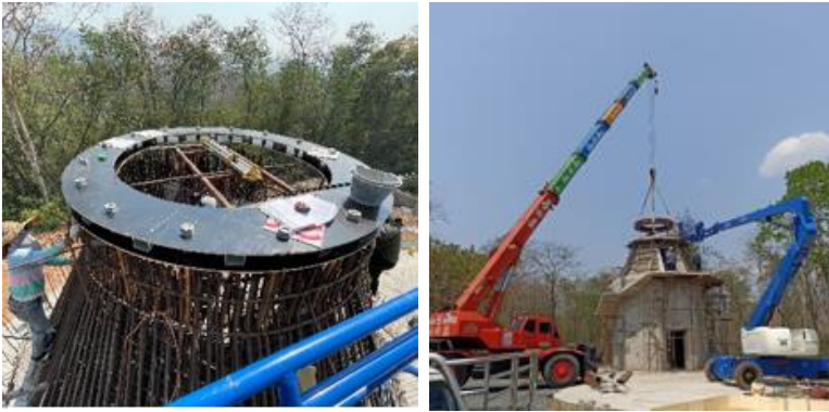
23 มีนาคม 2566 ติดตั้ง Transition ring ร่วมกับวิศวกรจีน
