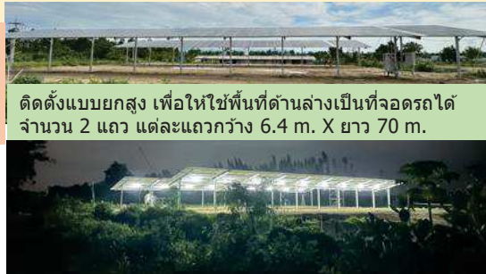
ตอนกลางคืนของระบบ PV ในเฟส 2 โดยมีไฟส่องสว่างด้านใต้แผง เพื่อความสะดวกและความปลอดภัยกับผู้ใช้งาน
