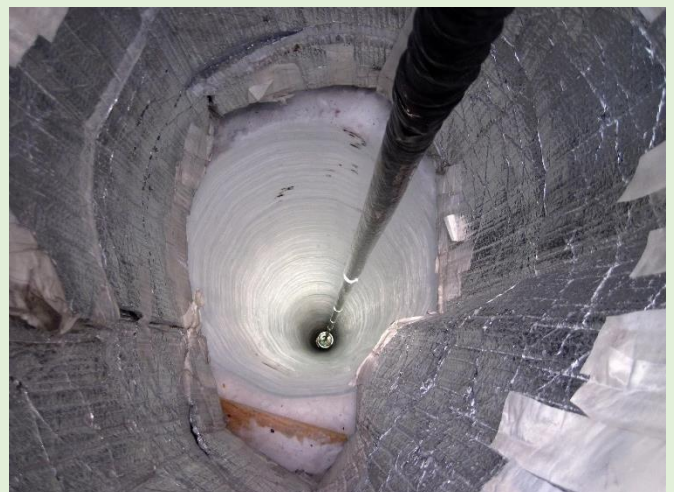
สายโยงของไอซ์คิวบ์ระหว่างก่อสร้าง (ภาพ-NSF-B. Gudbjartsson)
