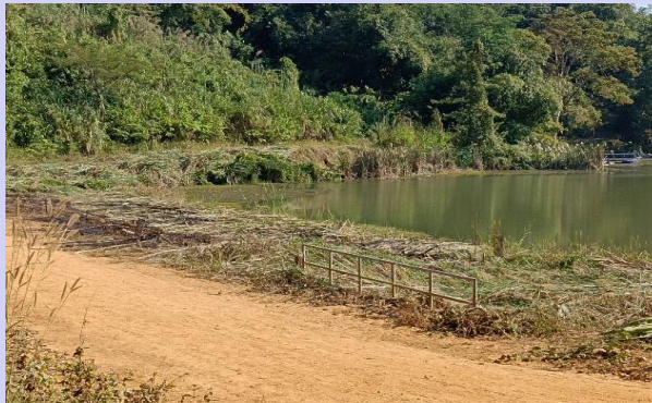
2.1 กำจัดวัชพืช ปรับปรุงทำความสะอาดอ่างเก็บน้ำรร.ตชด.โดย กรมชลประทาน
