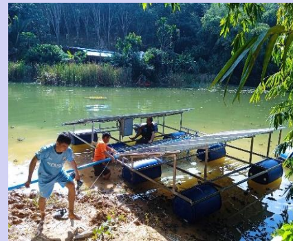
2.2 ติดตั้งระบบสูบน้ำโซล่าเซลล์ รร.ตชด.โดย สสน.
