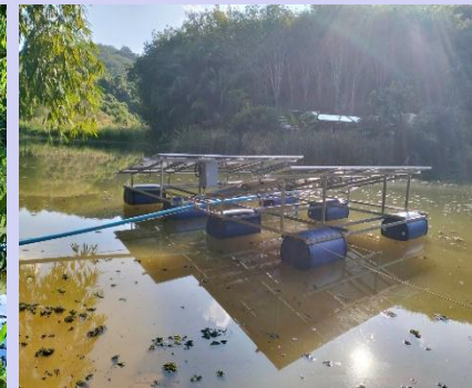
2.2 ติดตั้งระบบสูบน้ำโซล่าเซลล์ รร.ตชด.โดย สสน.
