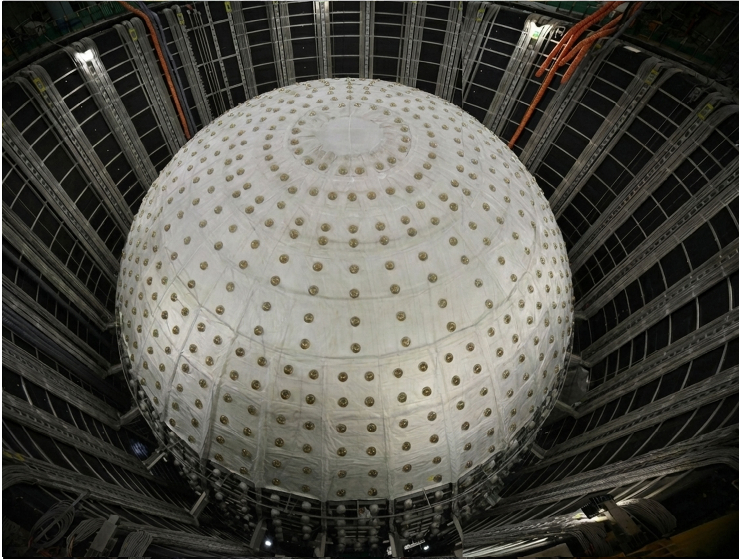
รูปที่ ๒๒ ภาพถ่ายทรงกลมอะคริลิกที่ล้อมรอบด้วยตาข่ายขดลวดป้องกันสนามแม่เหล็กโลก (Earth Magnetic Field (EMF) Shielding)
