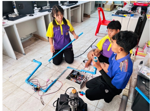
ประกอบชุดรับคำสั่งควบคุมการทำงานปั้มน้ำ
