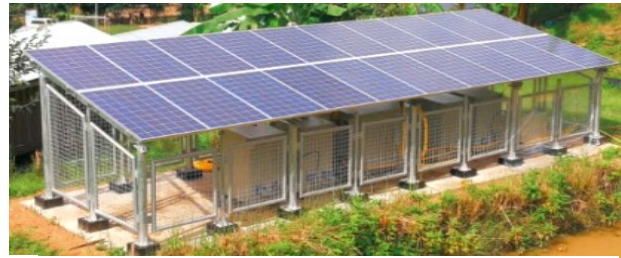
Solar cell 5kWp สำหรับโรงเรียนขนาดใหญ่
